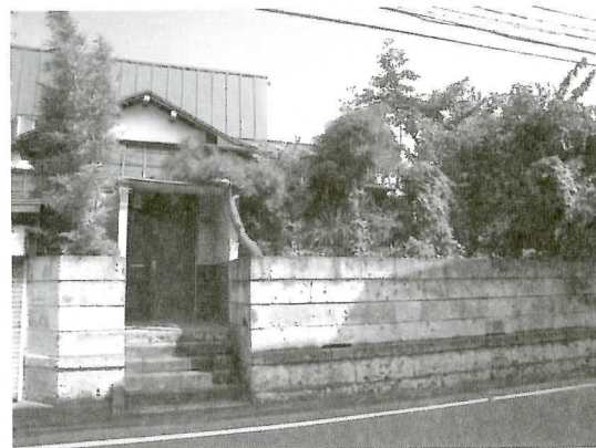
写真3 民地部分の盛り土
