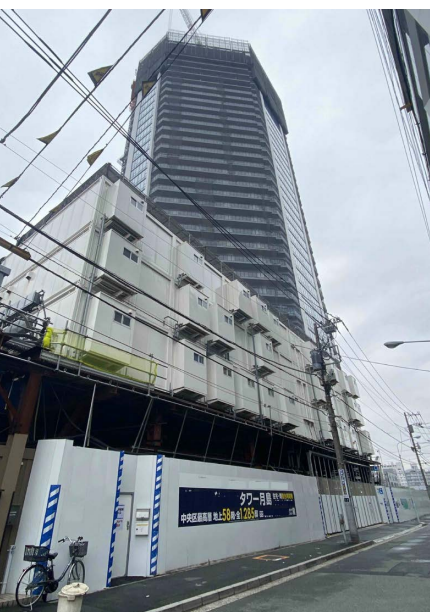
写真2：月島で進んでいる再開発工事
